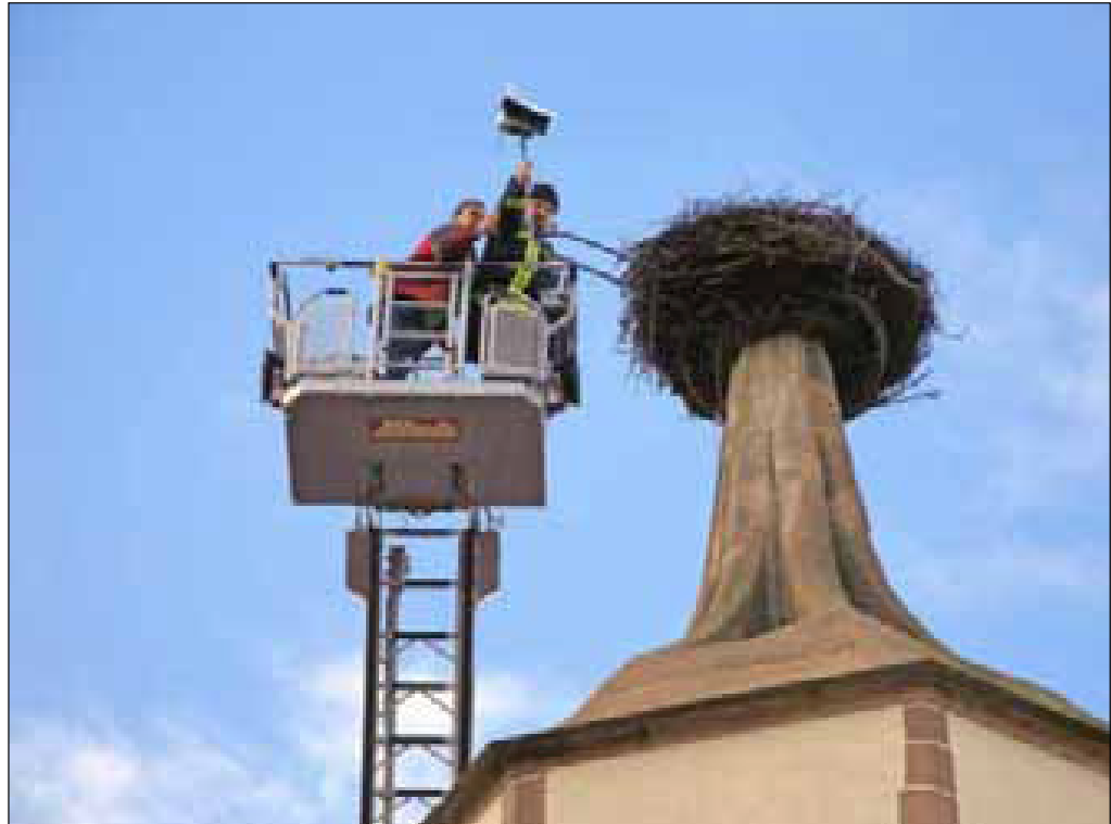
Bei der Montage der neuen Kamera.
