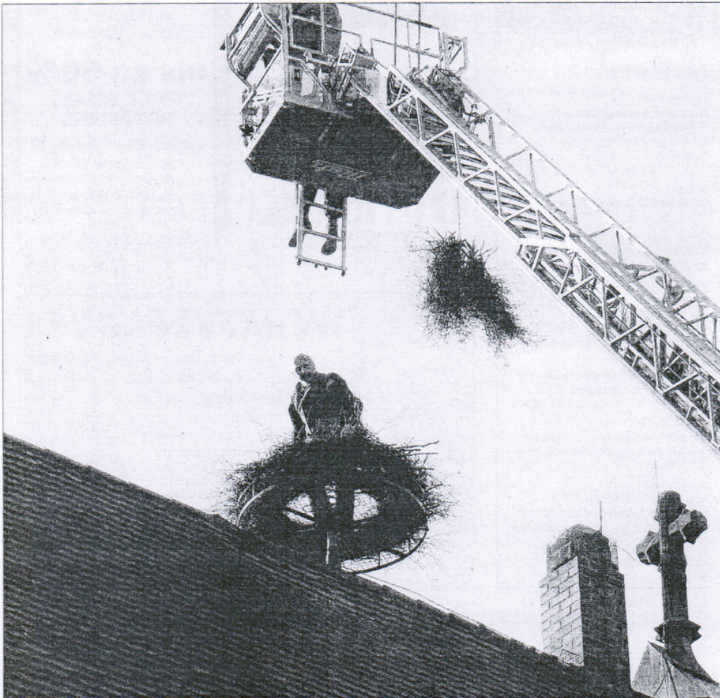
Das neue Nest wurde nach der Befestigung des Metallkorbes - etwa 30cm über dem First des Kirchendaches - durch Hagen Späth fachgerecht mit Reisiggeflechten bestückt.
