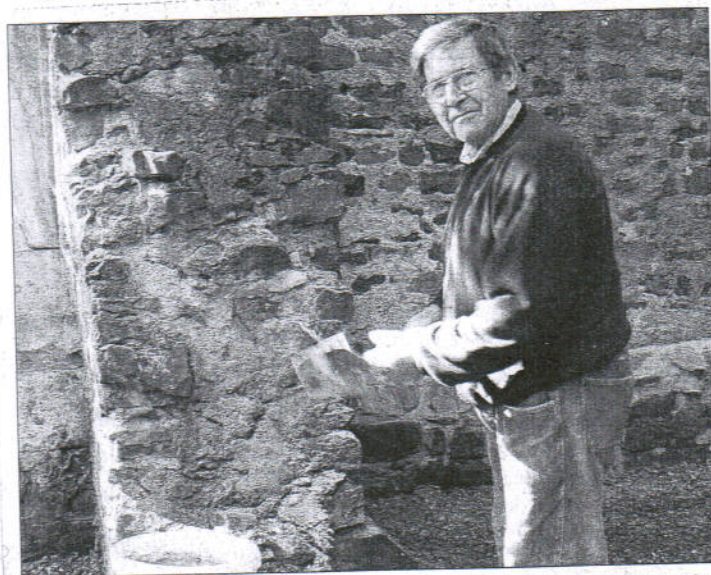
Mauersanierungen und Stabilisierungen durch Mörtelarbeiten müssen immer wieder vorgenommen werden, um die Ruine der einstigen Bergkapelle
