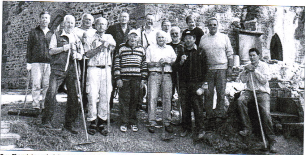
Das Einsatzteam bei der Sanierungsaktion auf St. Severin im April 2007.
