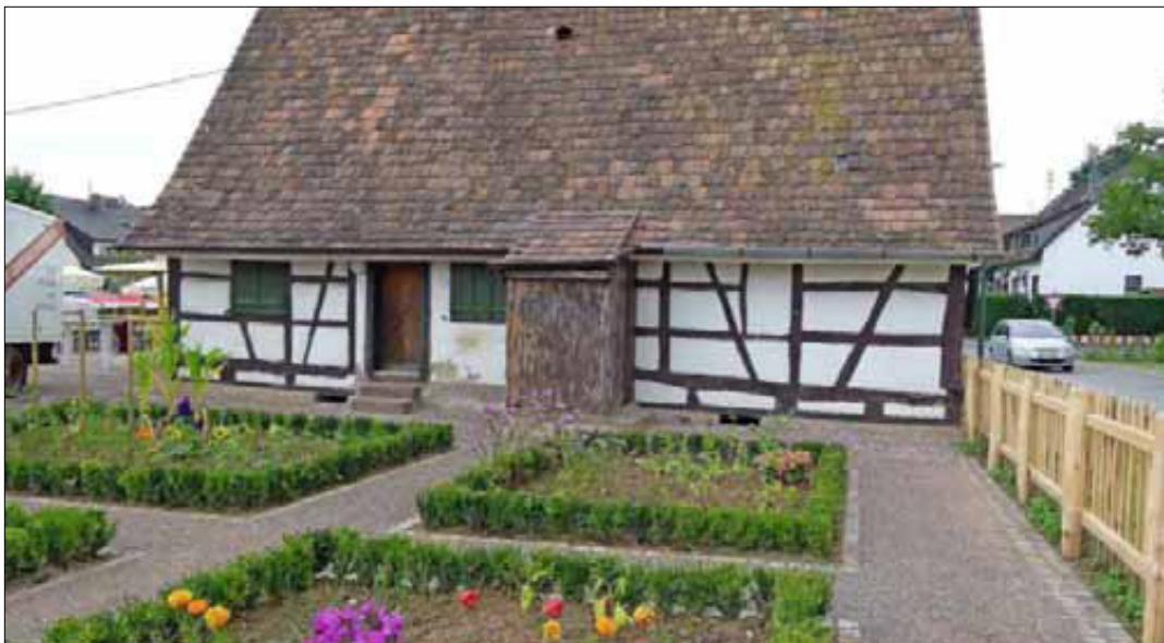
Das Gaus-Haus mit Bauerngarten von der Südseite.
